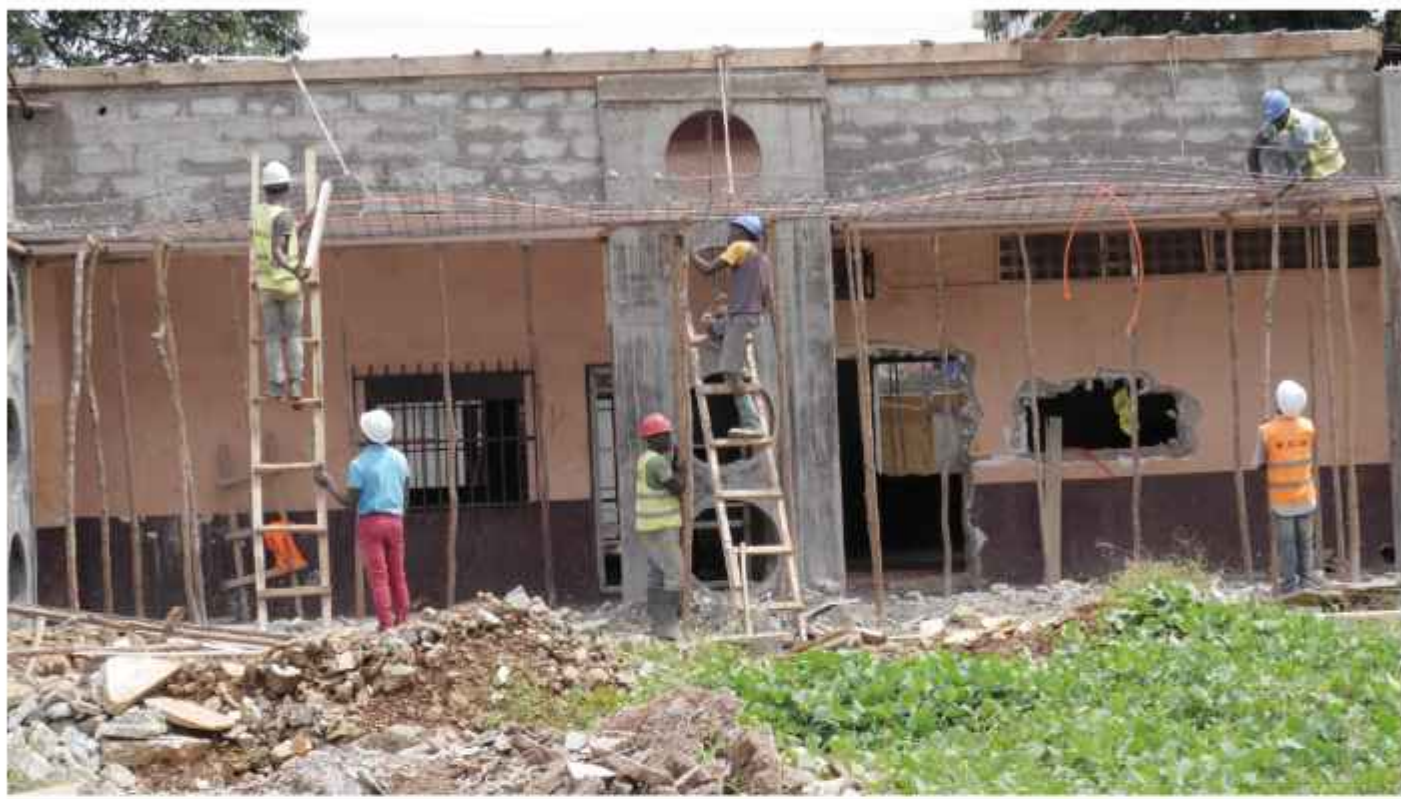
Bâtiment Salles des Classes (pendant la renovation)
