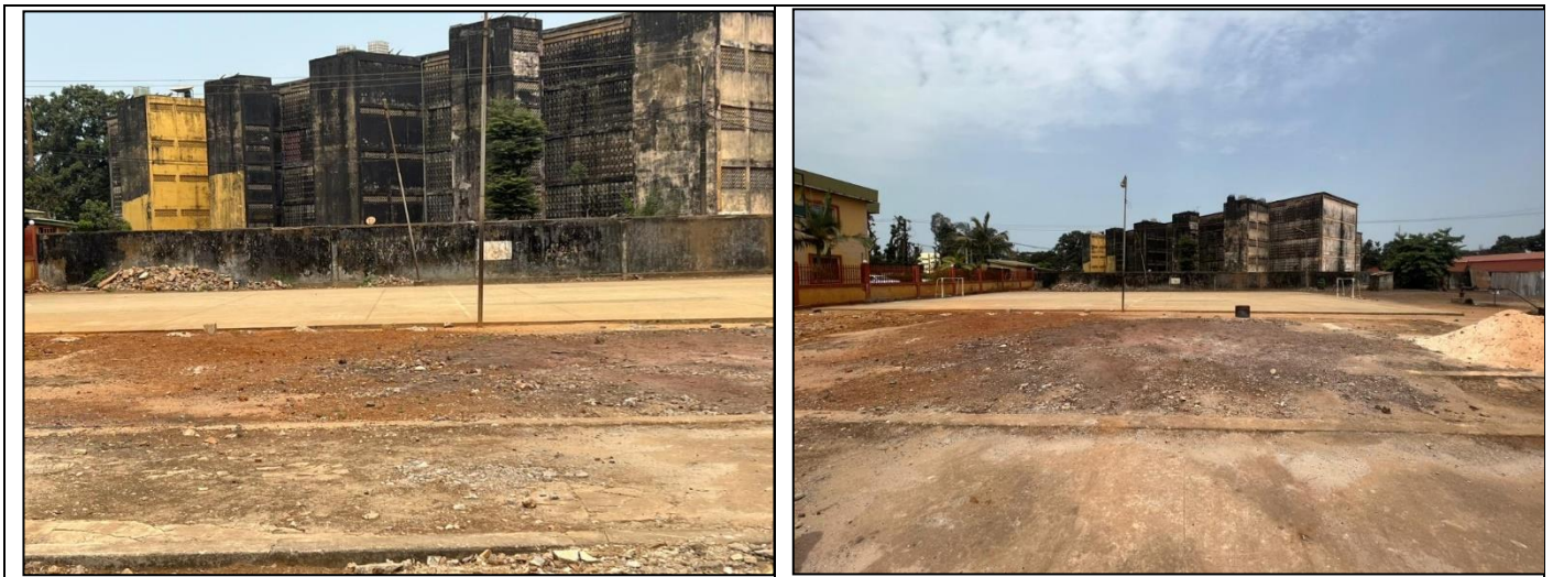
Photo 2 vue du site d'implantation du bâtiment siège
