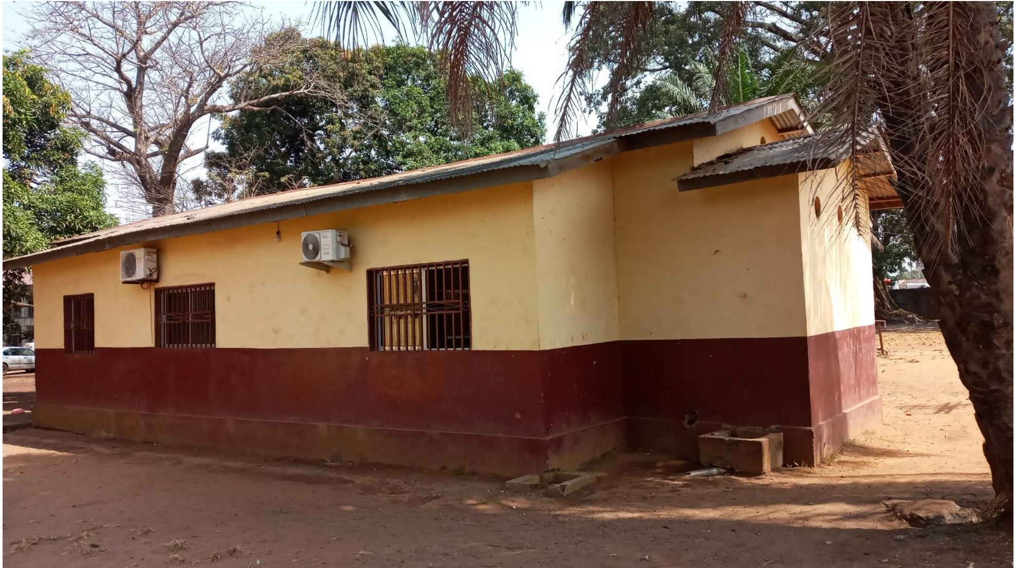
Bâtiment des bureaux de l'Unité de gestion (Vue de derrière)
