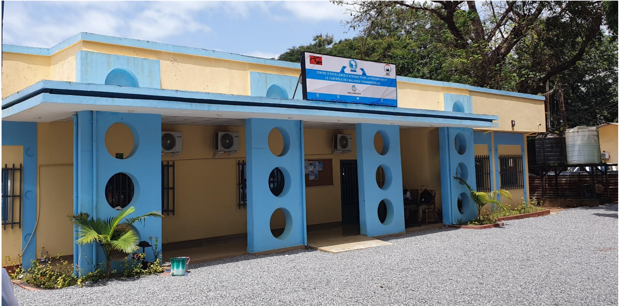
Bâtiment des amphithéâtres (Vue de face)
