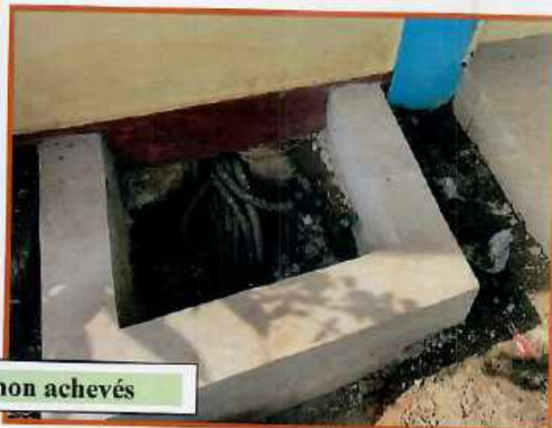
Manque de finition de maçonnerie et électricité
