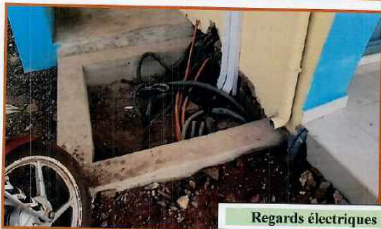
Manque de finition de maçonnerie et électricité
