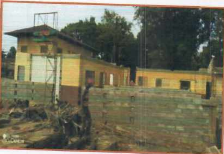
Vue du Bâtiment des bureaux après démolition et travaux de fondations de la zone d'extension
